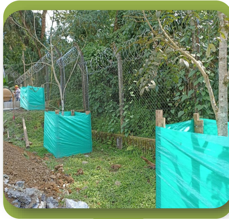
Protección de árboles en zona cercana al pozo de la CM-12.
