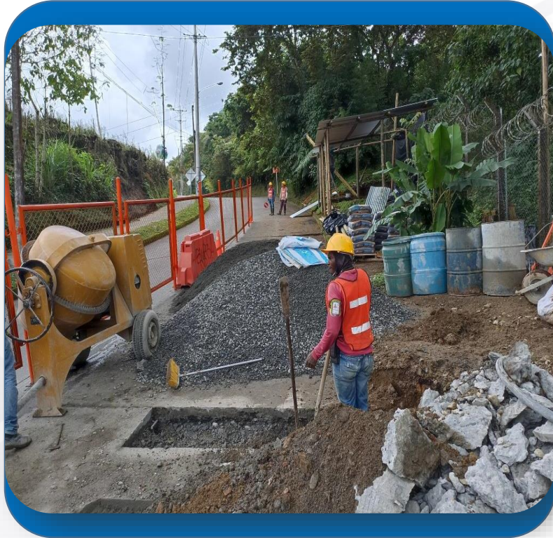
Construcción de bases para instalación de estructura metálica, para extracción de material del túnel e ingreso de tubería GRP en CM-12.
