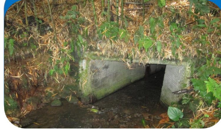
Cabezal de descarga
