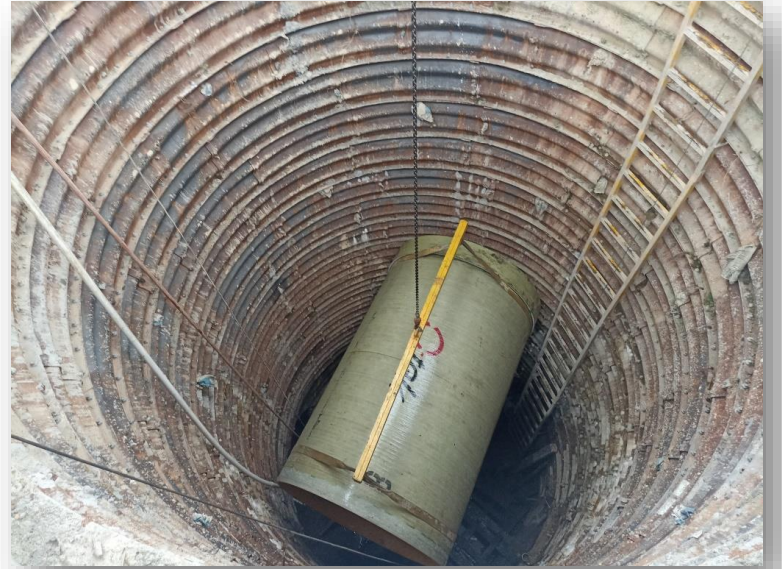
Trabajo de descenso de la tubería GRP por el pozo 12, para luego ser transportada e instalada en los túneles.
