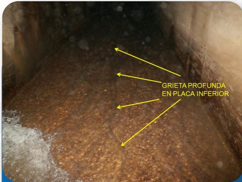
Grieta longitudinal en placa inferior
