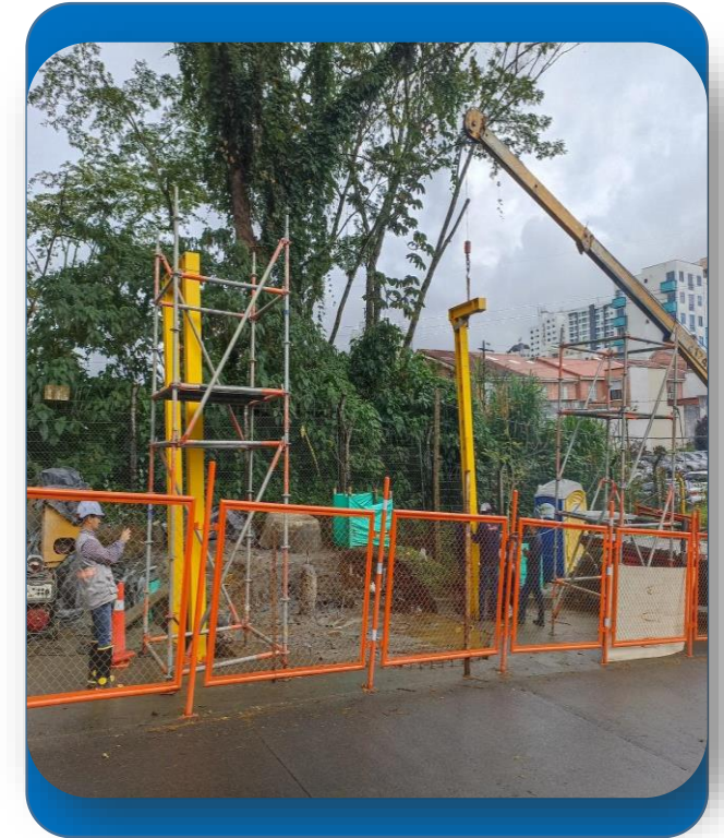
Instalación de estructura metálica (polipasto), para extracción del material excavado y portal acceso túnel vertical. Pozo CM-12.
