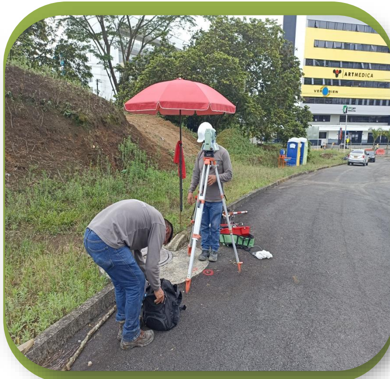
Replanteos topográficos de obras en la Q. El Bosque.
