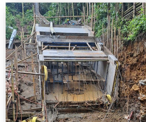
Estructura de Descarga
