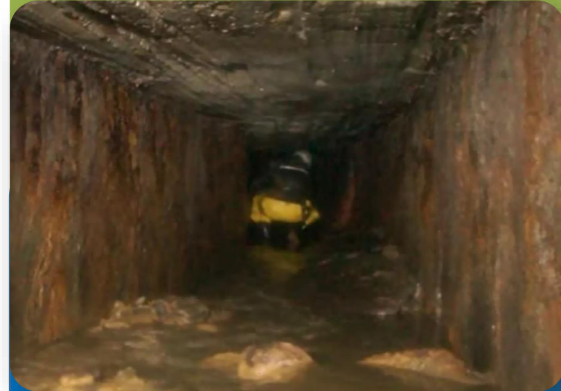
Canal estrecho (h=0.80m)
