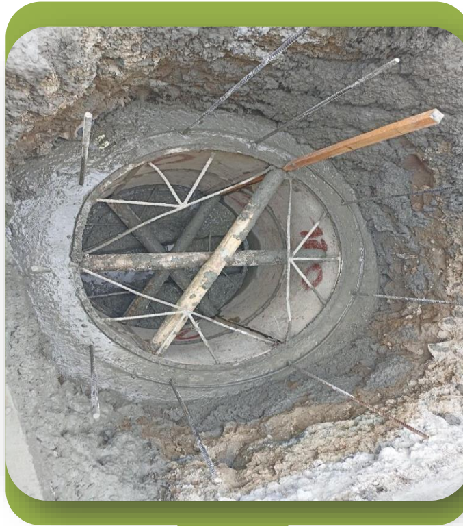
Construcción de cámara de alcantarillado en concreto D=1.20 m.
