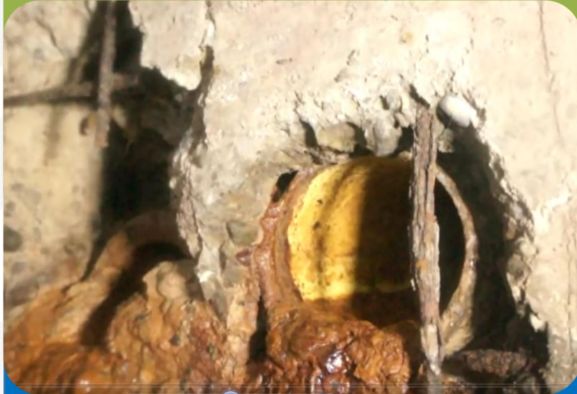
Detalle de un orificio para infiltración lateral al canal
