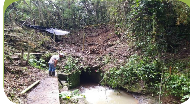
Cabezal de descarga
