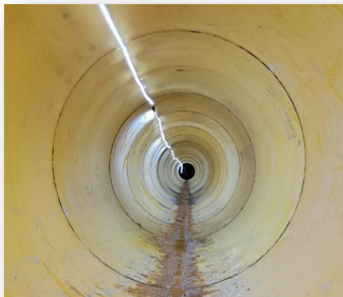
Instalación de Tubería GRP
