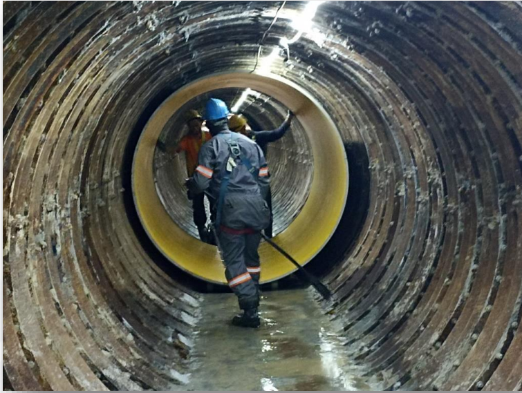
Proceso de transporte de la tubería GRP de D=1900 mm, para su instalación entre pozos 12 a 11 y 12 a descole.
