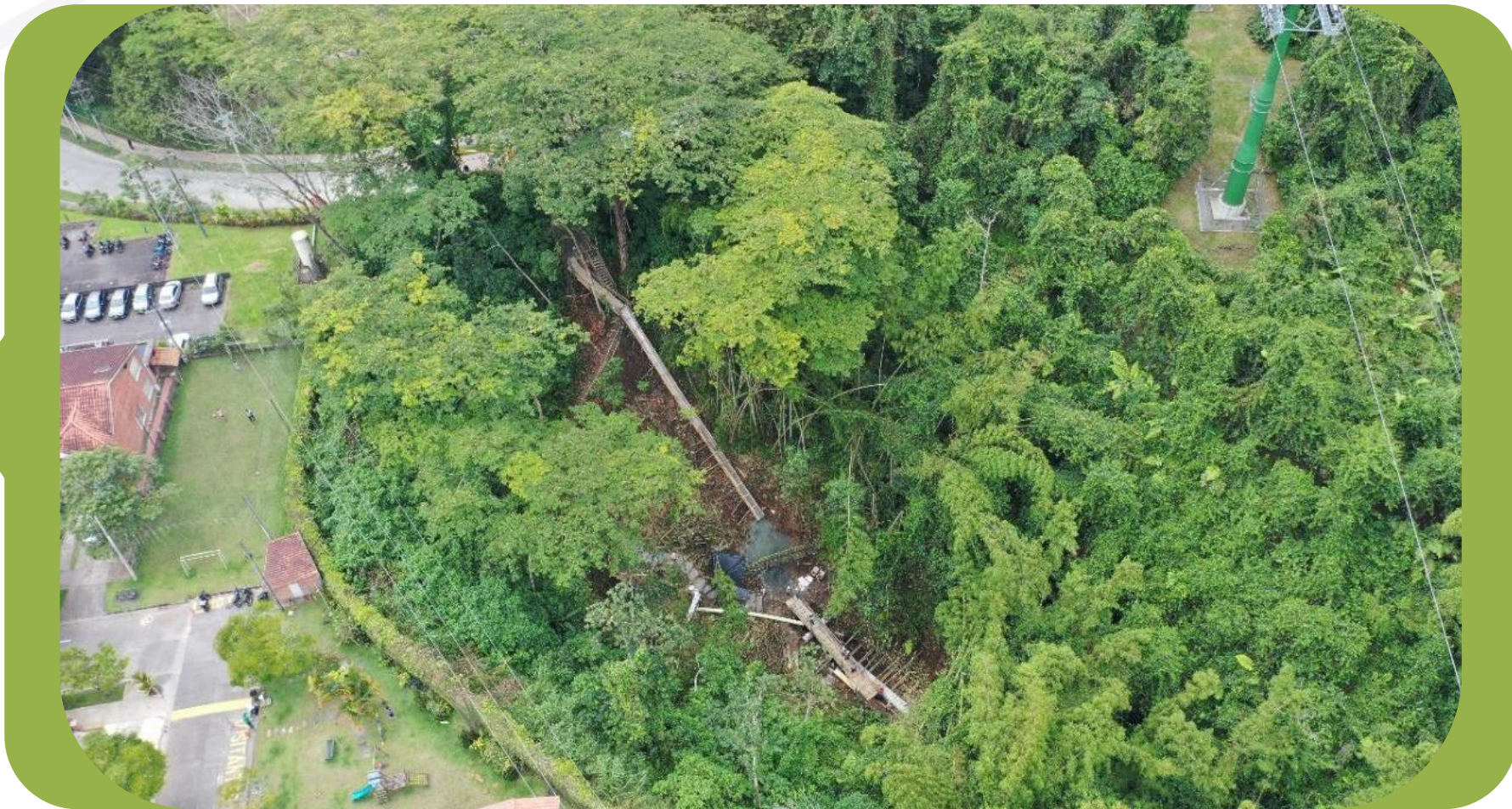
Estructura de Descarga y Obra del descole Quebrada La Dulcera – fase 1, sector Pinares Médica. Unidad Residencial la Colonia
