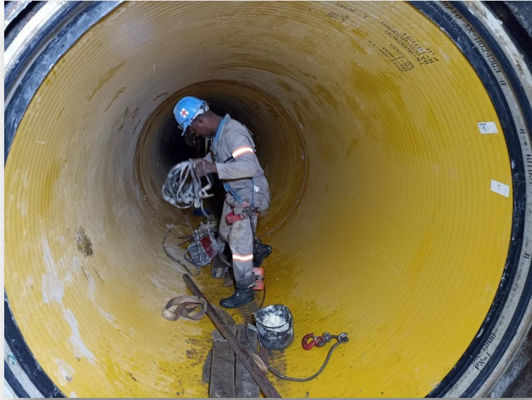
Se observan varios tubos ya instalados en el túnel entre pozos 12 y 11 (tubería GRP de D=1900 mm).
