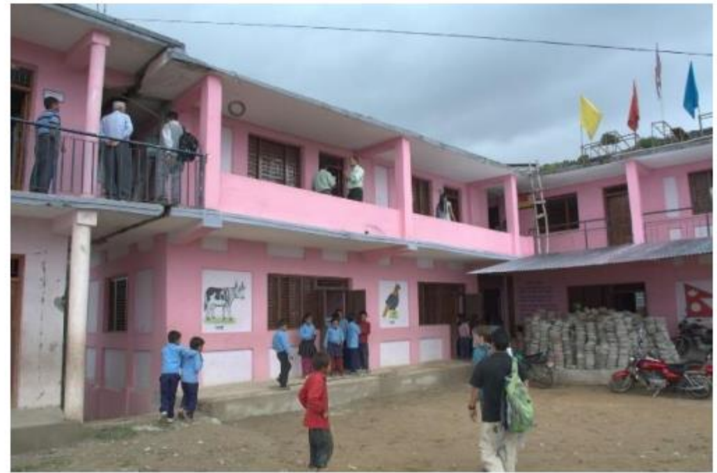
Colegio reforzado con malla y pañete
