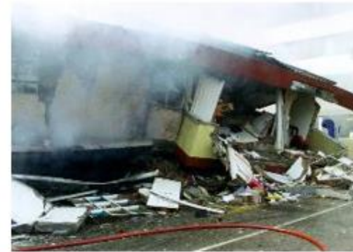
Sismo del Eje Cafetero (1999) (Pereira)
