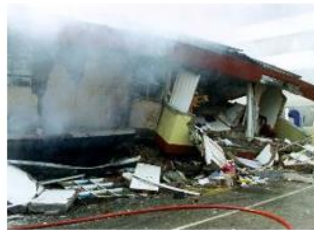
Sismo del Eje Cafetero (1999) (Pereira)
