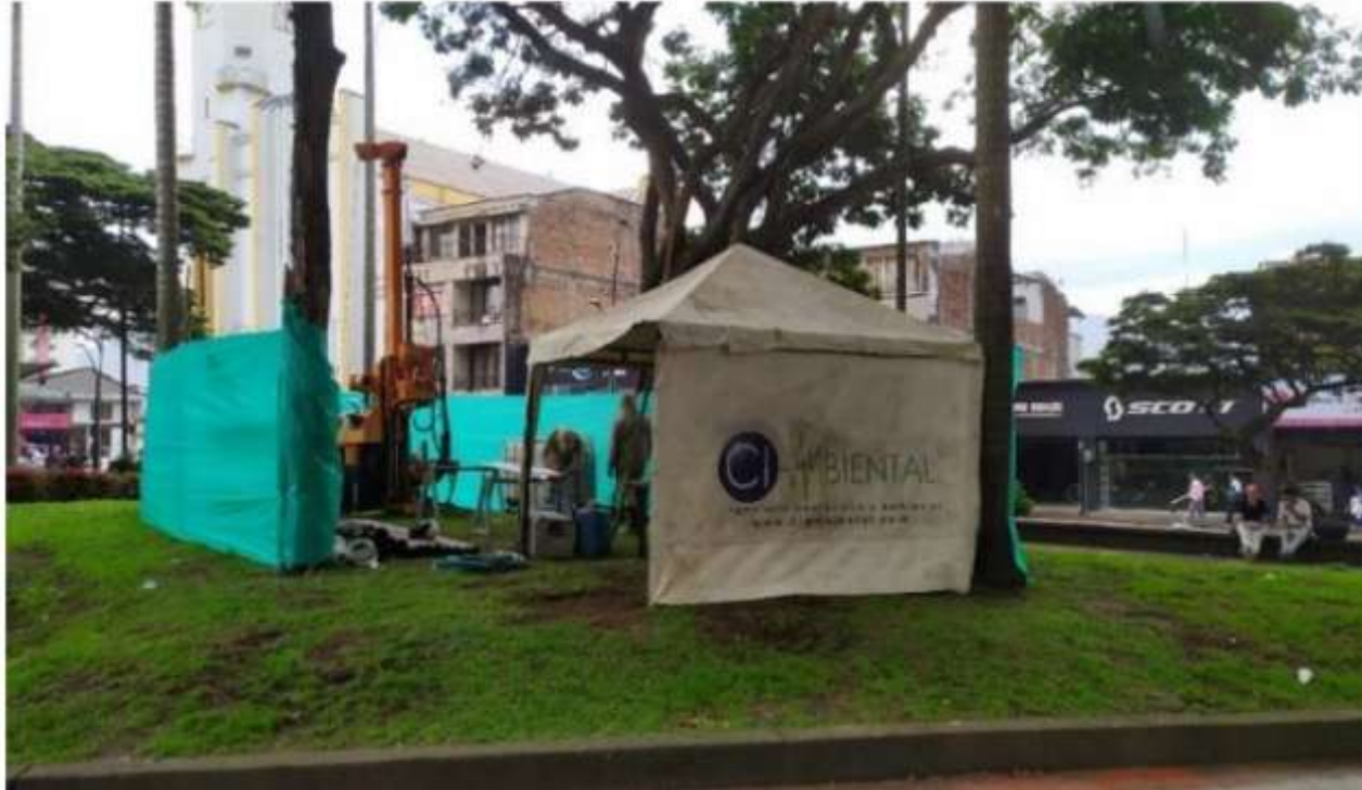
Perforación en Parque la Libertad
