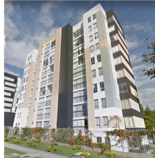
Muros en CR
