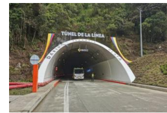
Túnel de la línea
