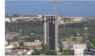
Edificio Acuarela Cartagena (Bolívar)
