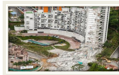
Colapso de la torre 6 del edificio SPACE
